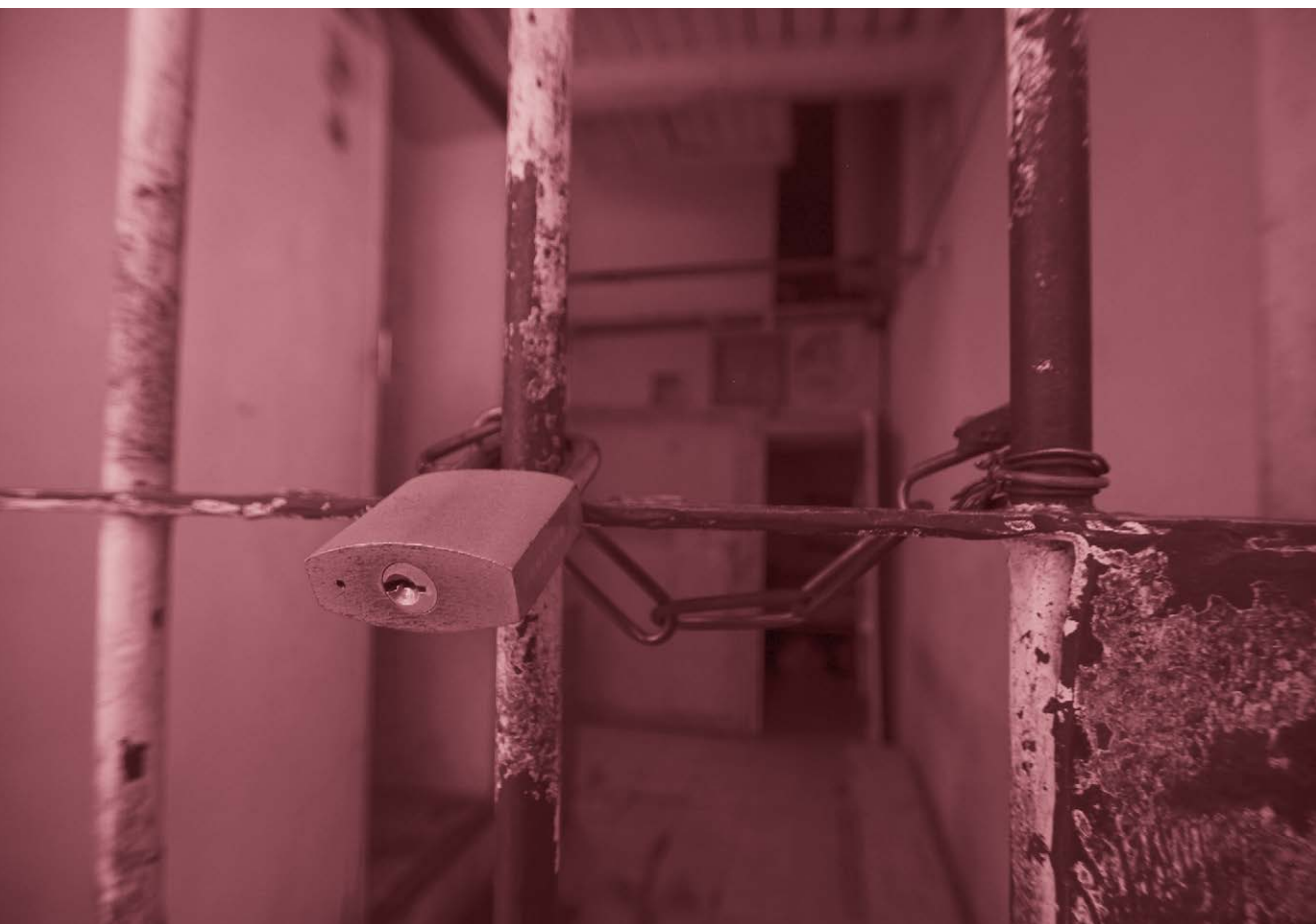
Entrada de las galeras. Fotografía tomada en el Penal Francisco J. Múgica, Morelia, Michoacán. Rodrigo Caballero, 2017.
